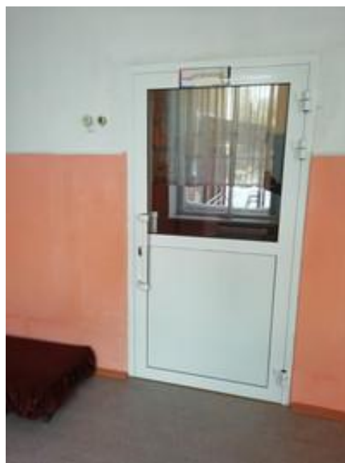
-расширение дверных проём;
