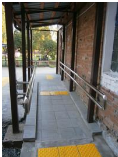
-обустройство центрального входа;
